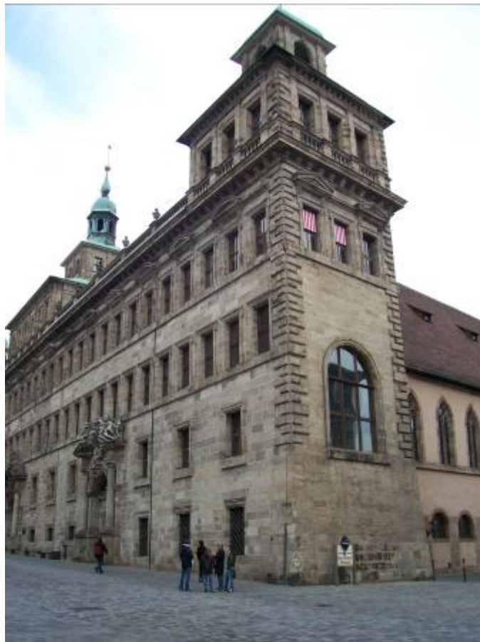
Rathaus Wolffscher Bau, Nürnberg
